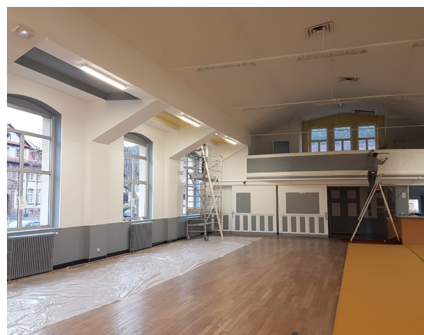
Rénovation intérieure - Salle de Gymnastique
