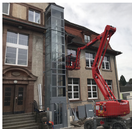
Pose de l'élévateur - Ecole Koechlin
