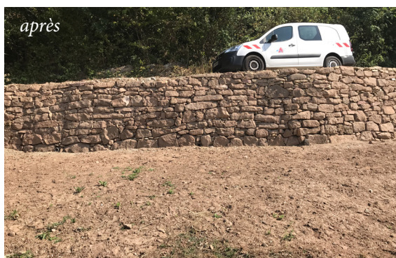
Mur du chemin du Réservoir
