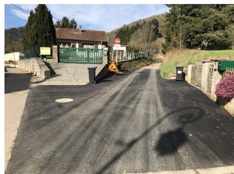
Rue du Breuel - Enrobé
