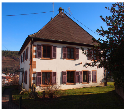
Travaux de rénovation intérieurs du Presbytère
