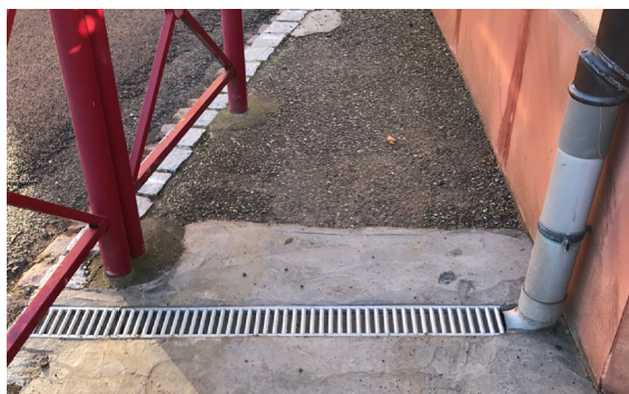
Rue du Florival Reprise des caniveaux pour l'eau pluviale
