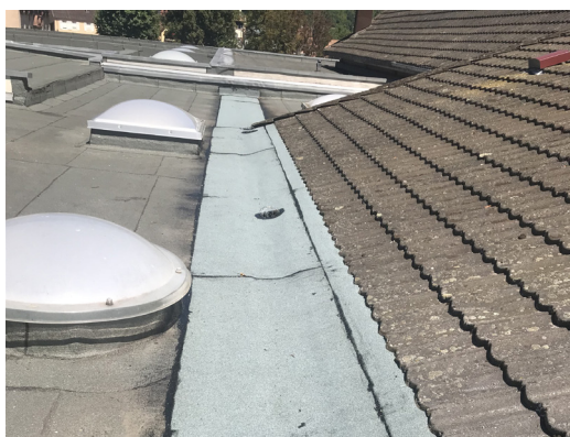
Toiture Ecole maternelle - Travaux d'étanchéité
