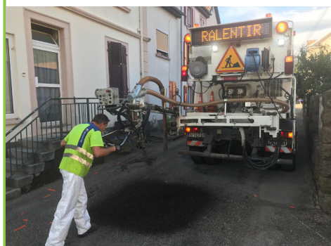
Rue Saint Jean - Enrobé
