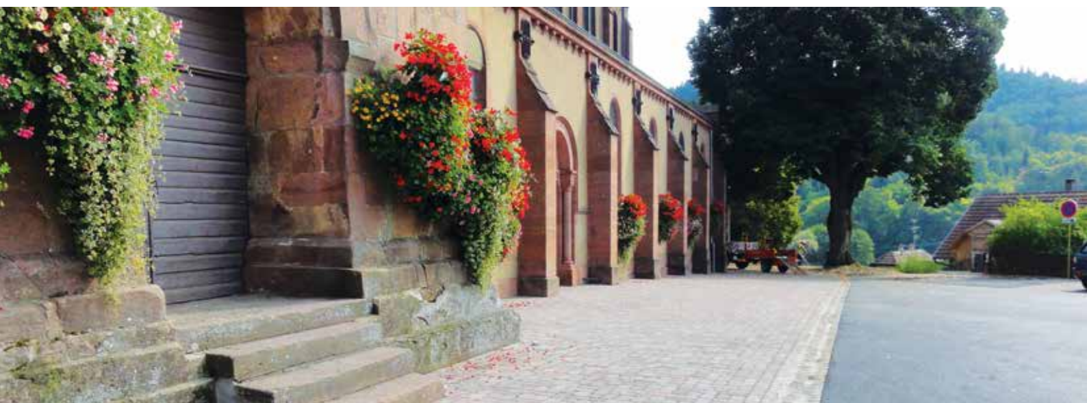
Après les travaux
