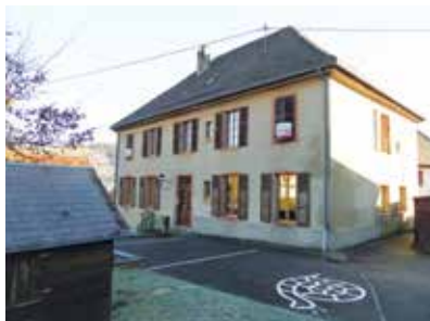
Bâtiment de l'ancienne école maternelle
