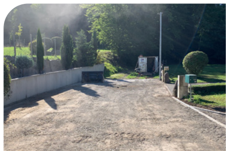
Réfection enrobée rue du Rimlishof
